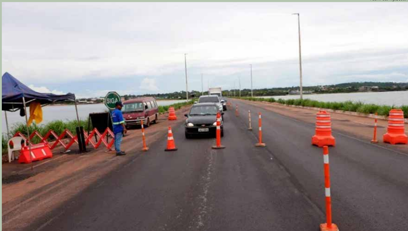
Sistema de Pare e Siga na ponte entre Palmas e Luzimagues.
