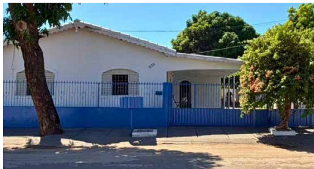
Pedido de cumprimento de sentença foi motivado após vistoria técnica flagrar idosos sozinhos.
