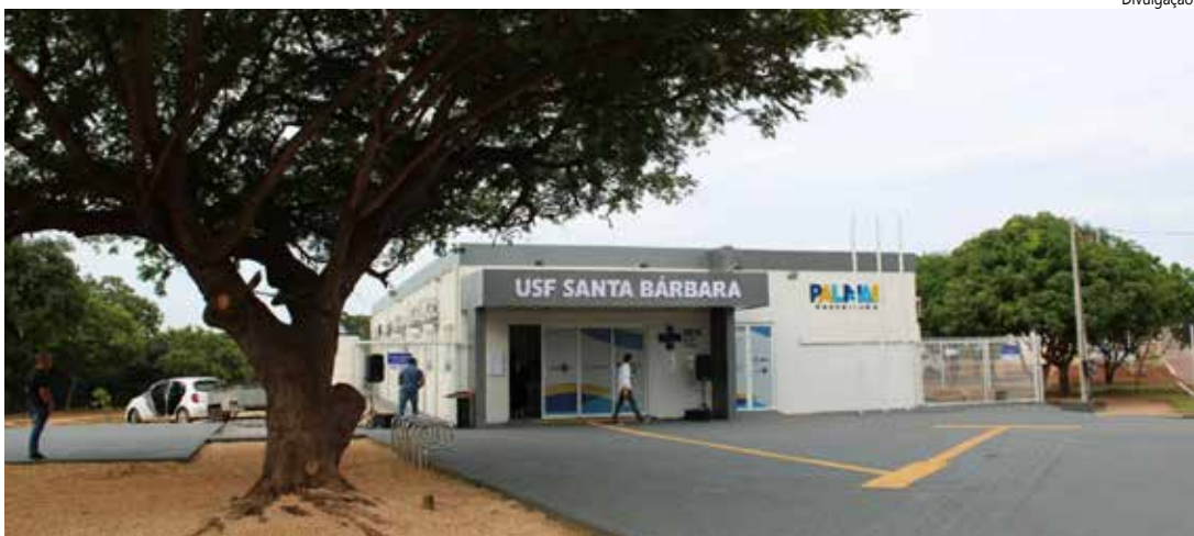
Estrutura reformada e equipes completas fortalecem a atenção primária da Capital.
